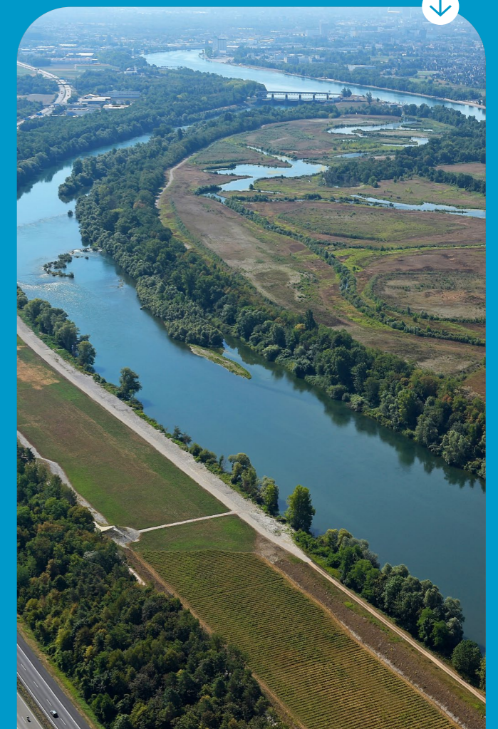
Ensemble du projet Petit Rhin vu de l'aval vers l'amont Photo : © EDF - Airdiasol
